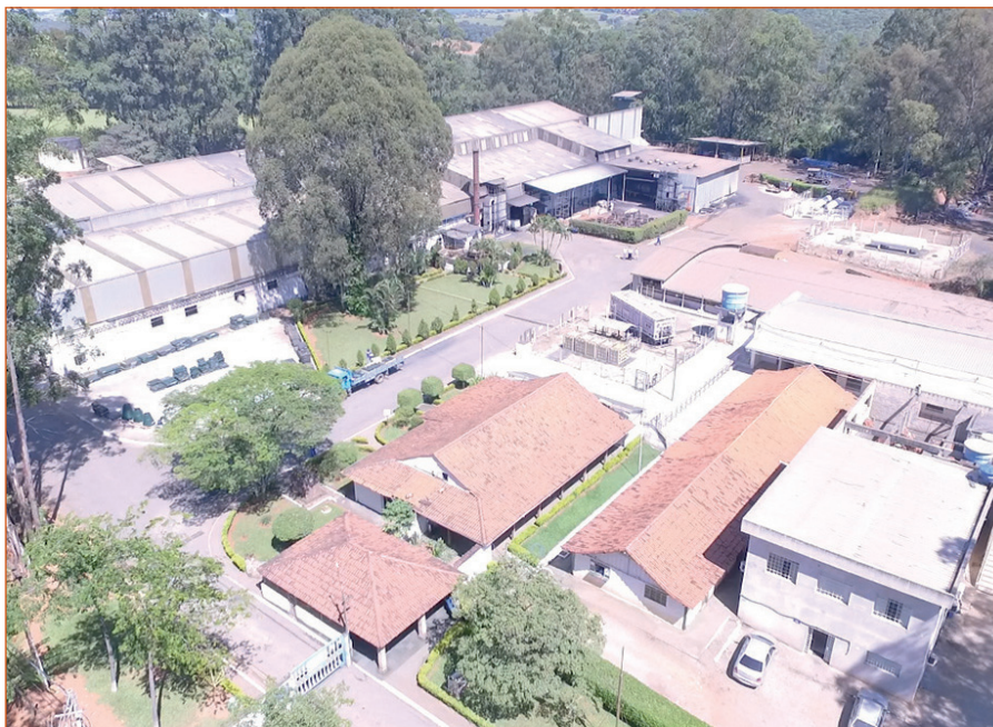
Vista aérea da Fornac
