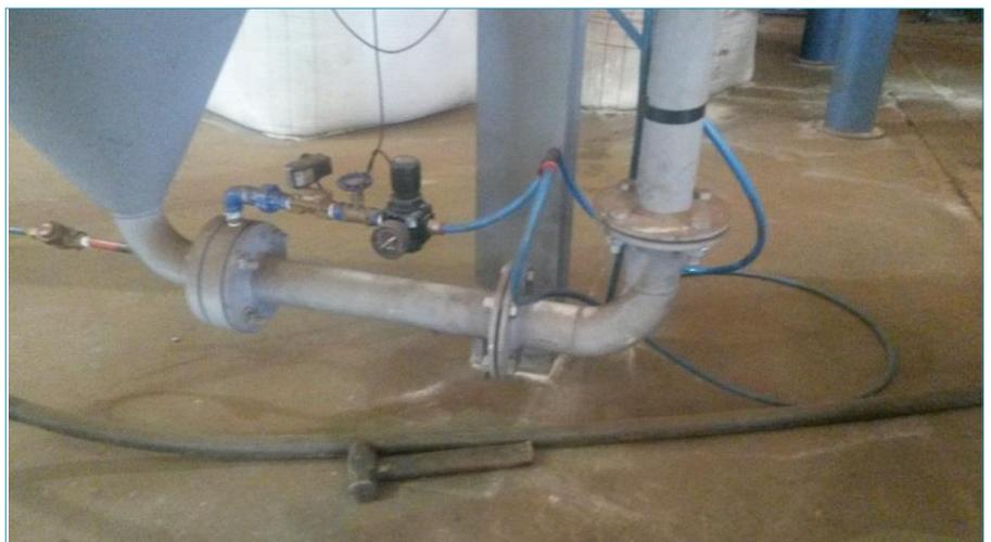
Fig. 10: Intensificador de linha. Fonte: Autor.
